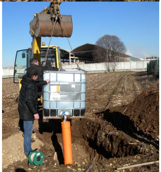
Esecuzione della prova di permeabilità in situ all'interno della trincea esplorativa n°2
