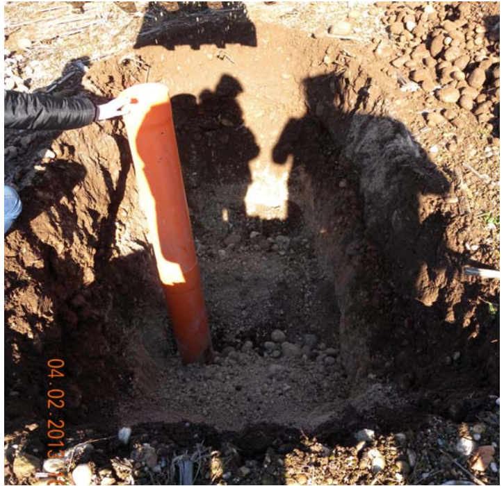
Trincea esplorativa n°2 con il permeametro utilizzato per le prove in situ
