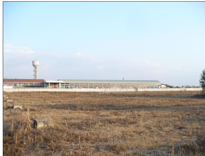
Vista Area 3P Immobiliare – Cartiere SACI
