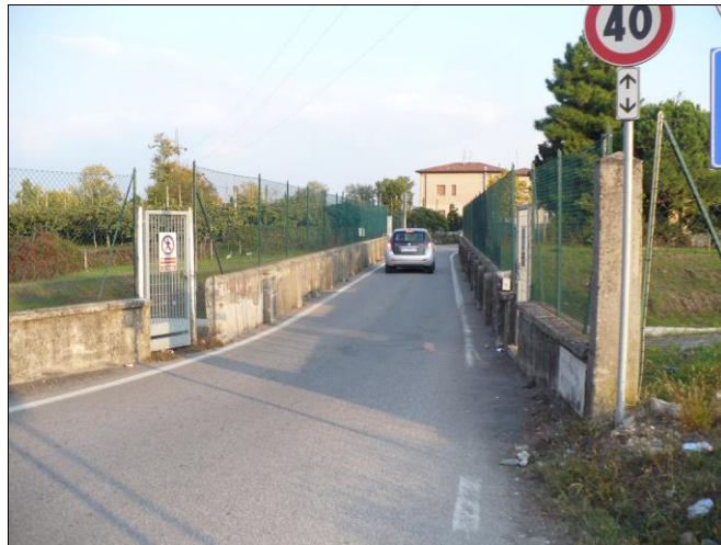
Via Mezzacampagna – ponte sul Canale Giuliani
