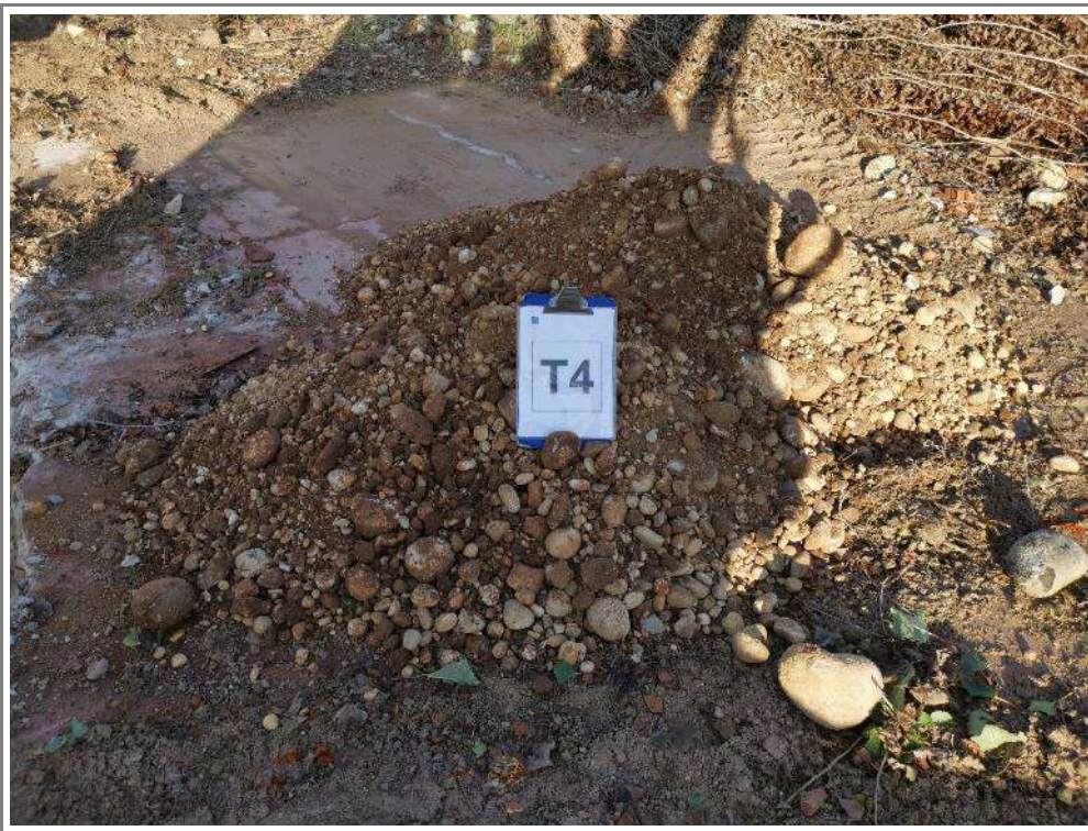
CUMULO DI MATERIALE ESCAVATO RIFERIBILE ALL'UNITÀ "R3"
