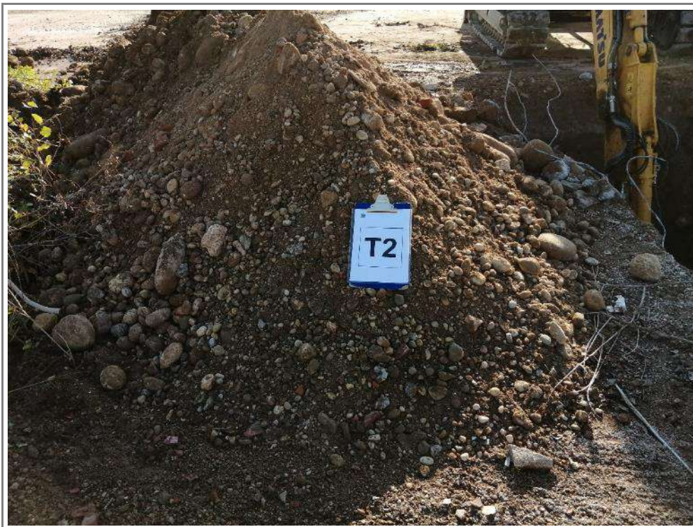
CUMULO DI MATERIALE ESCAVATO RIFERIBILE ALL'UNITÀ "R1"
