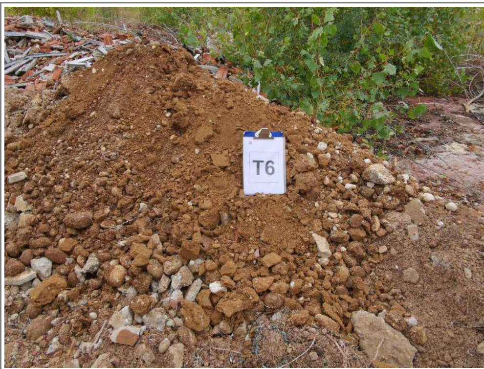
CUMULO DI MATERIALE ESCAVATO RIFERIBILE ALL'UNITÀ "R2"
