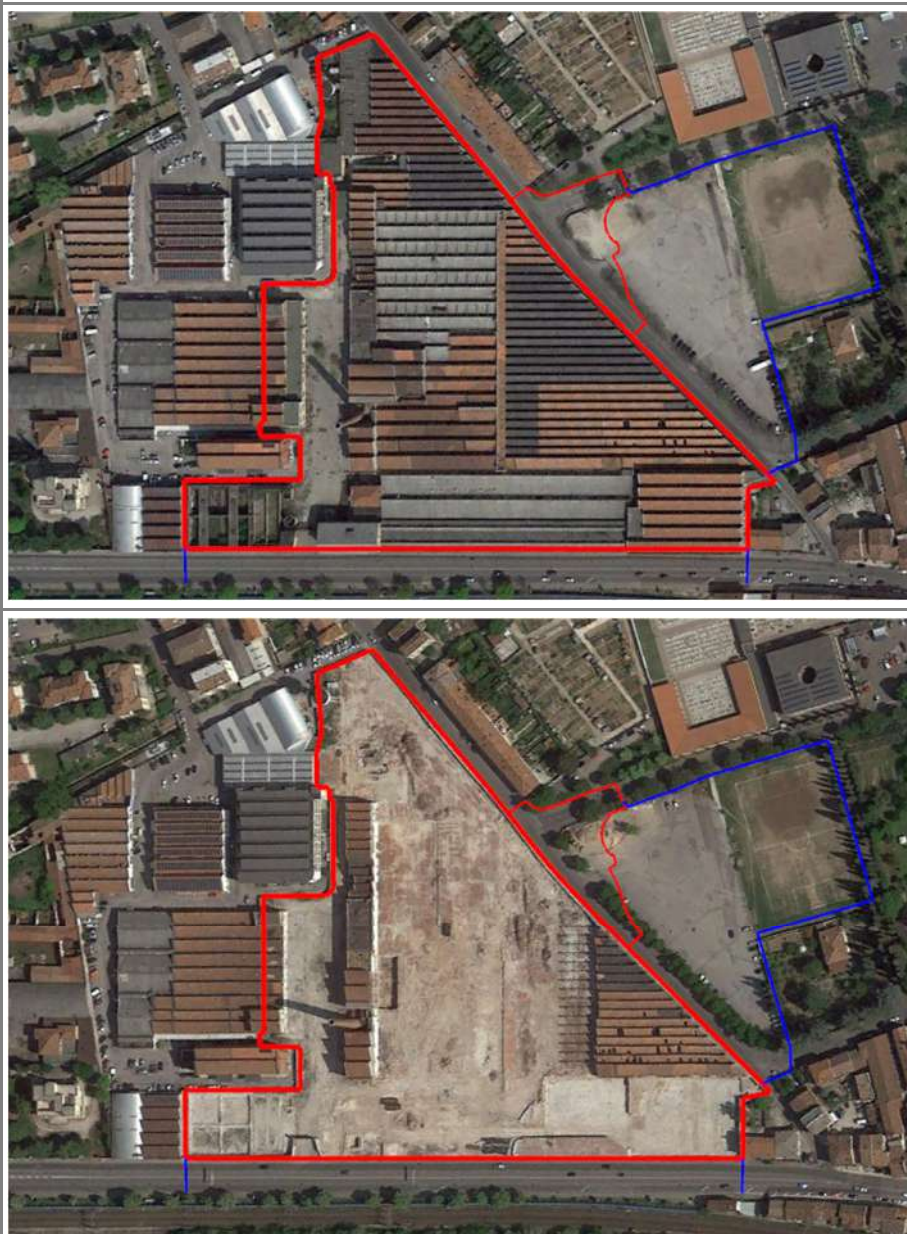
Fig. 5. Foto aerea dell'Ex Opificio Tiberghien, sito oggetto di studio ( in rosso e blu ), ante ( sotto ) e post demolizione ( in basso ).
