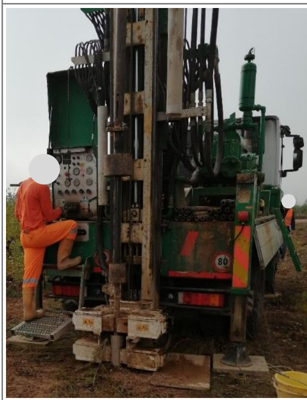
Fig. 36. Esecuzione di una delle prove SPT nel sondaggio "S1".
