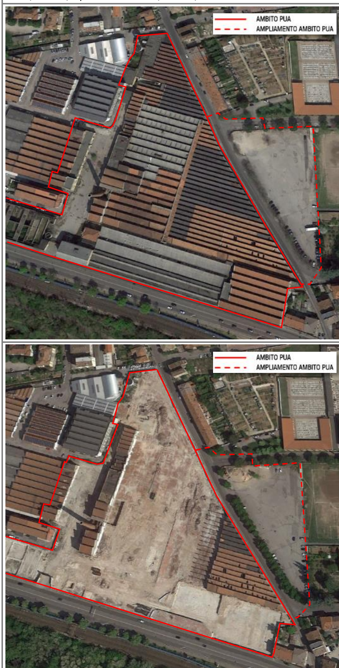
Fig. 9. Foto aerea dell'Ex Opificio Tiberghien, sito oggetto di studio ( in rosso ), ante (in basso) e post demolizione ( in basso ).
