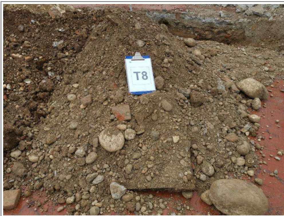
CUMULO DI MATERIALE ESCAVATO RIFERIBILE ALL'UNITÀ "R1"
