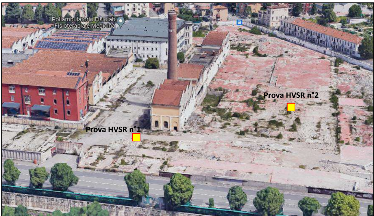
Fig. n°2: Ubicazione prove in sito
