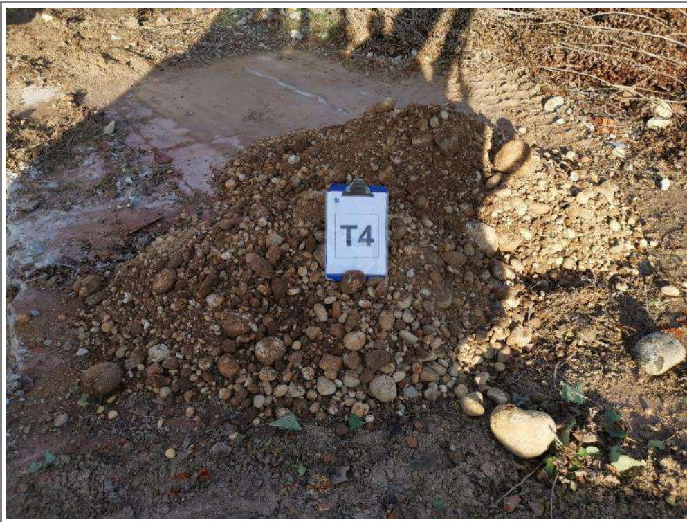
CUMULO DI MATERIALE ESCAVATO RIFERIBILE ALL'UNITÀ "R3"
