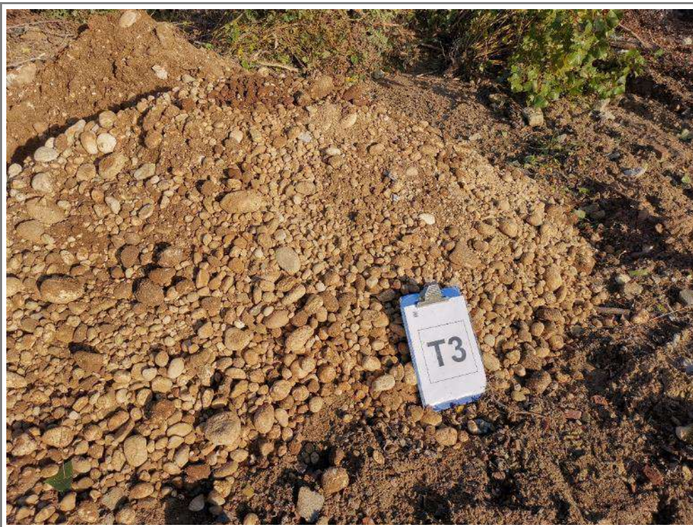
CUMULO DI MATERIALE ESCAVATO RIFERIBILE ALL'UNITÀ "G"
