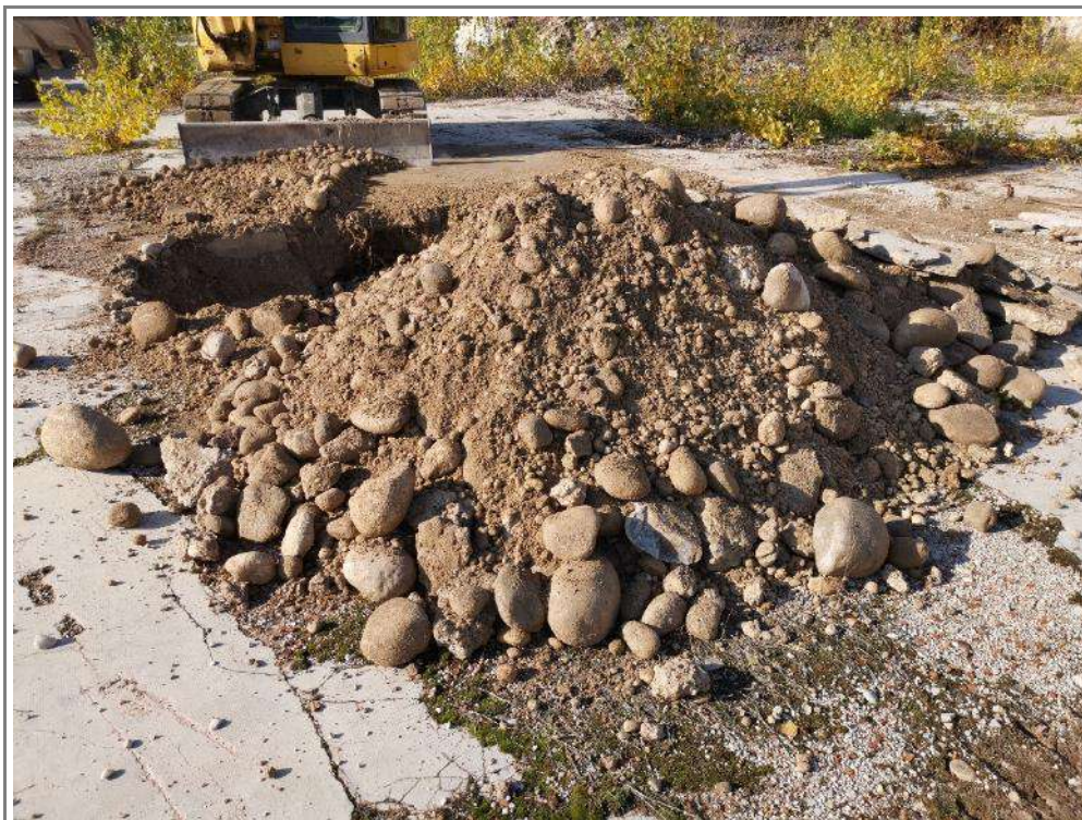
CUMULO DI MATERIALE ESCAVATO RIFERIBILE ALL'UNITÀ "G"
