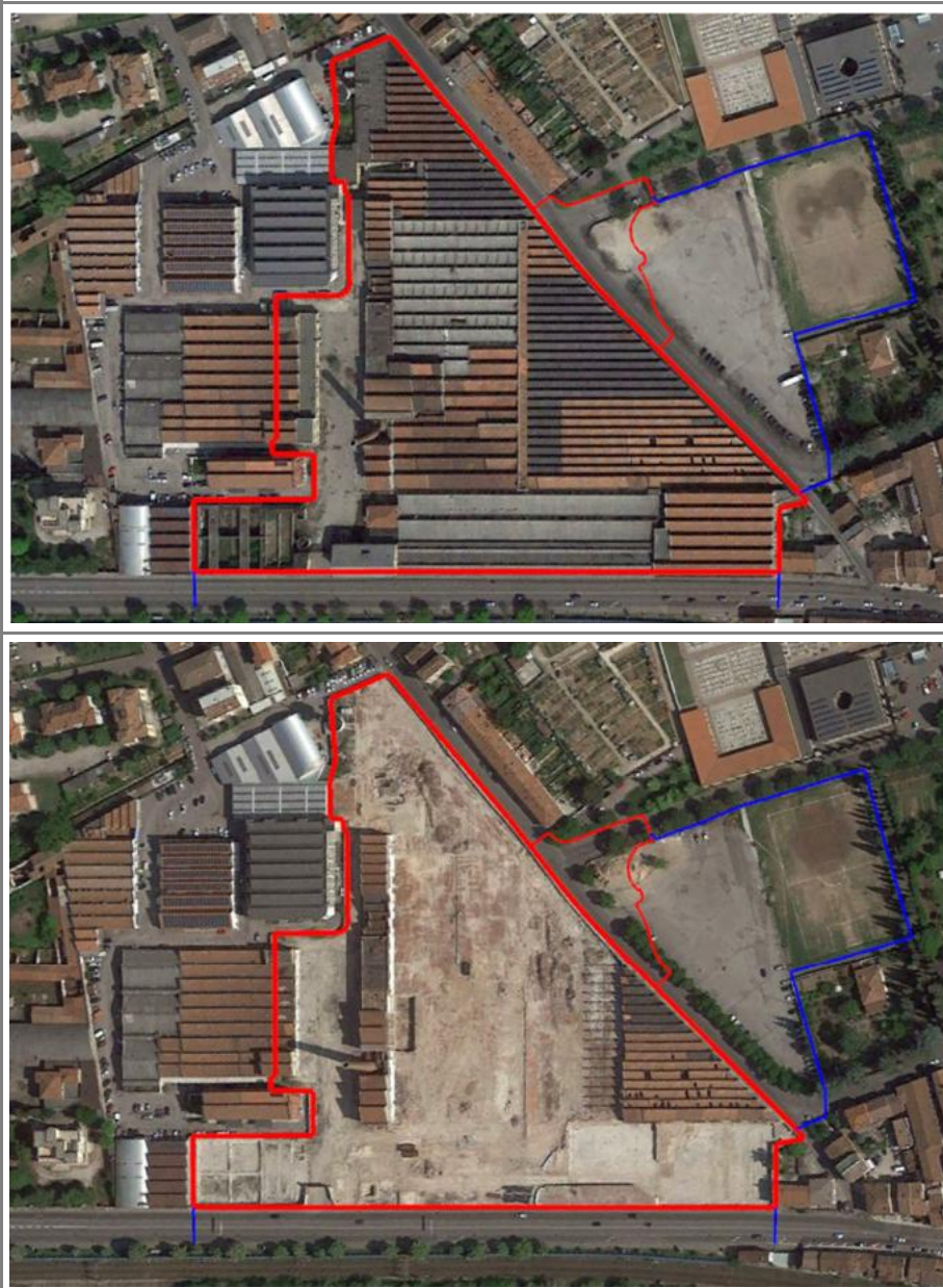
Fig. 3. Foto aerea dell'Ex Opificio Tiberghien, sito oggetto di studio ( in rosso ), ante (in basso) e post demolizione ( in basso ).
