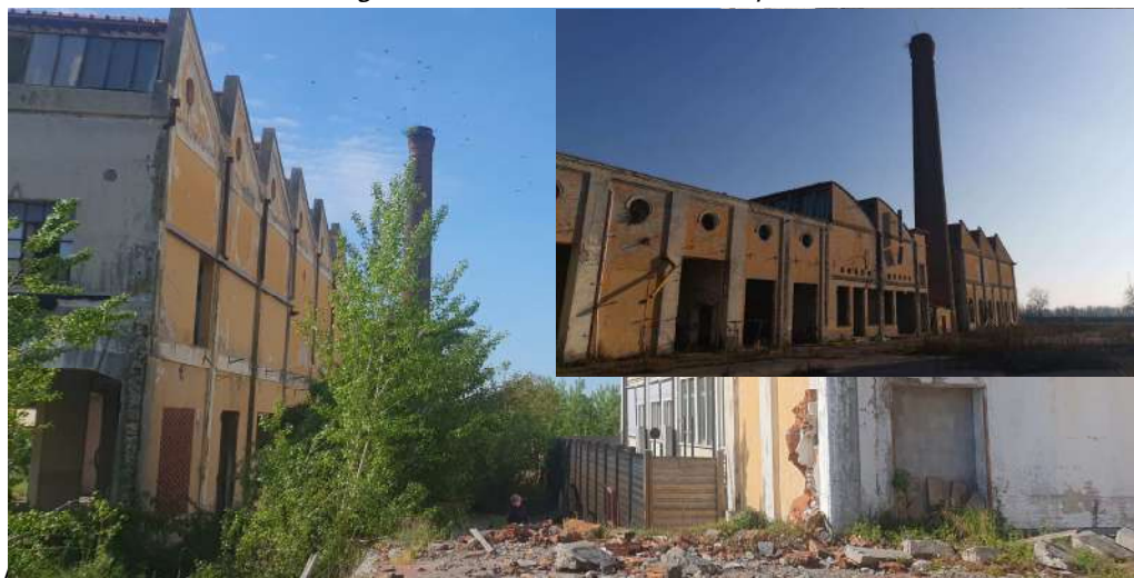
Figura 15: Foto cono ottico 5 con il vecchio camino vincolato
