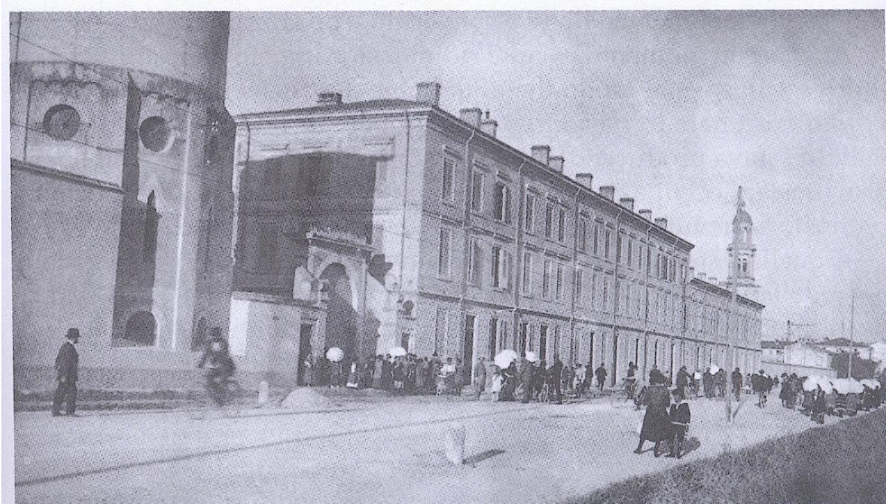
L'entrata dello stabilimento nel 1919 [T].
