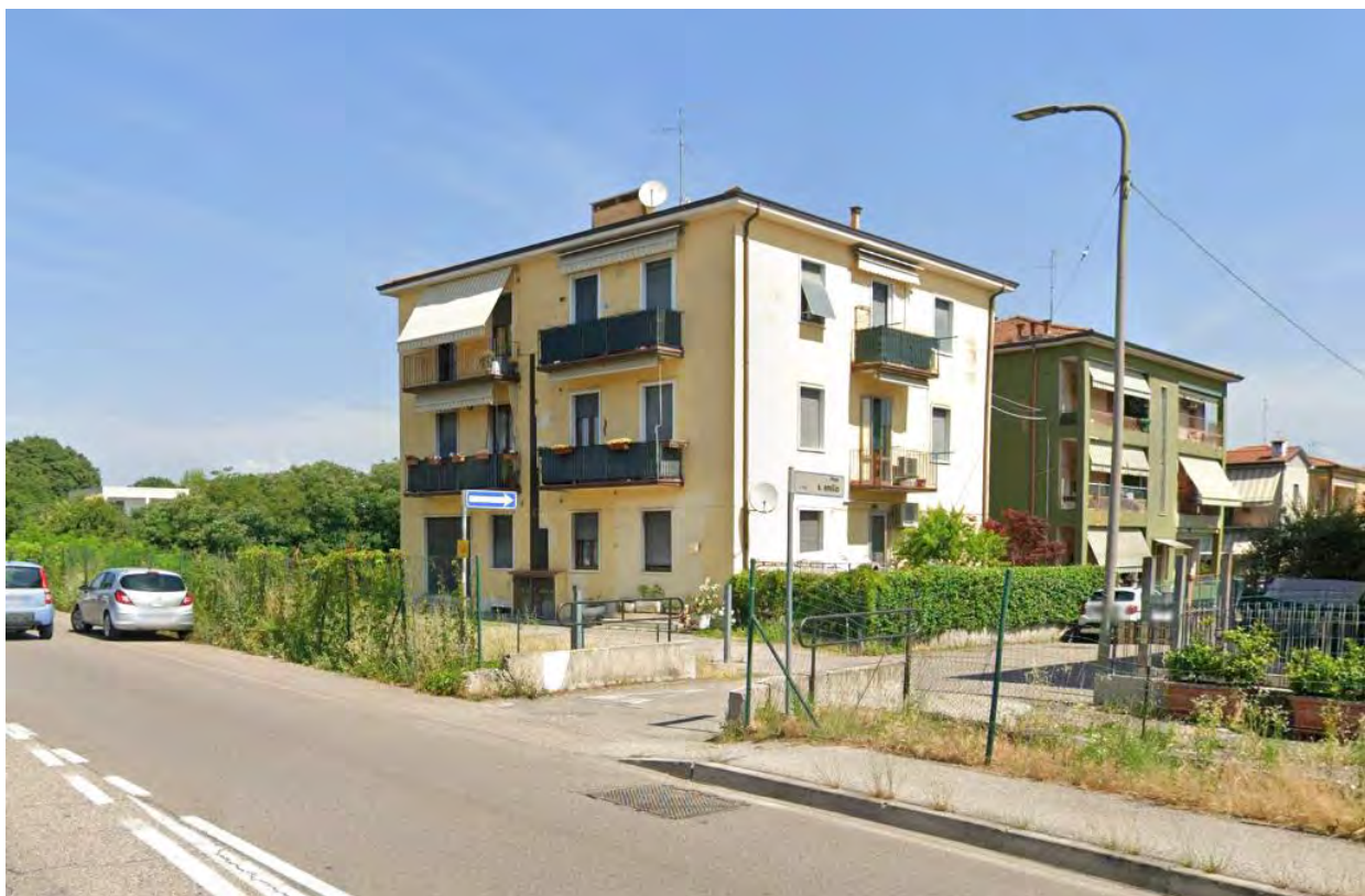
Foto del ponticello di collegamento tra Via Palazzina e Via Villaggio Sant'Emilio
