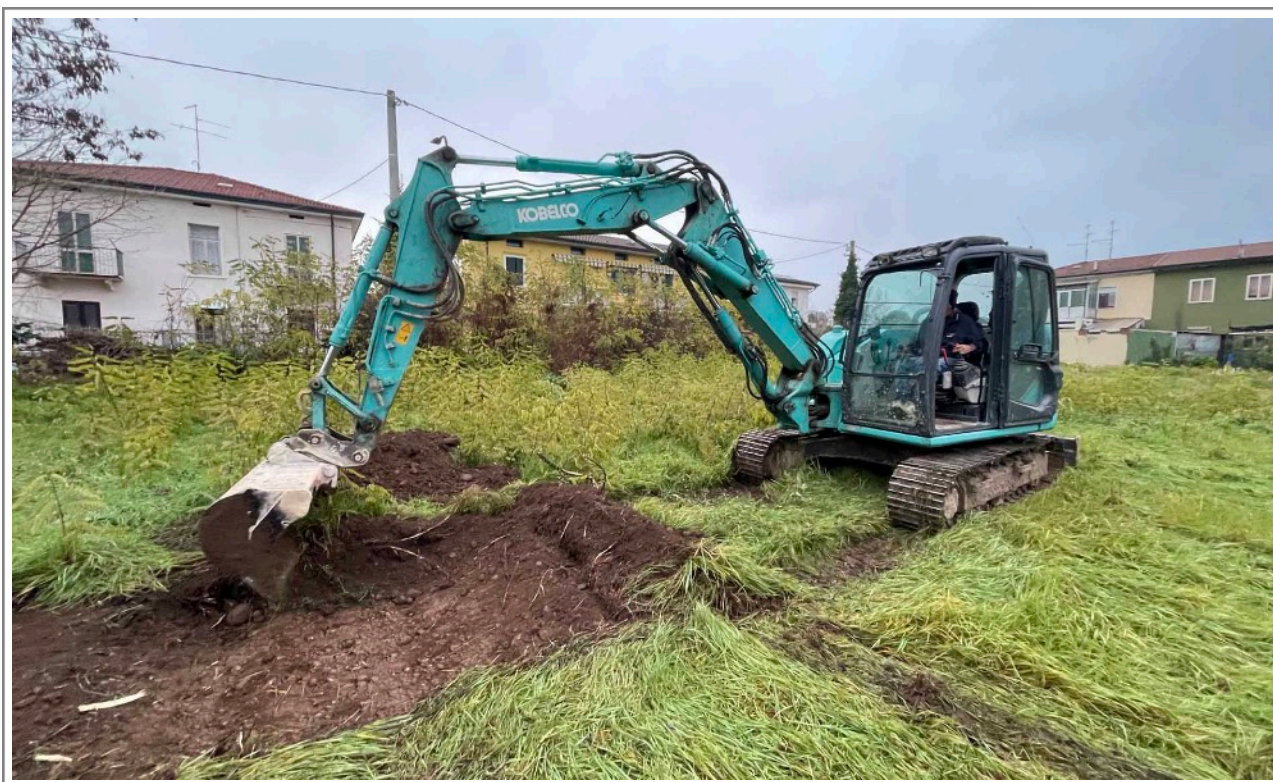
Figura 5. Fase di scavo della prima trincea esplorativa.
