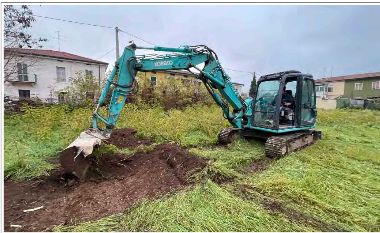
Figura 5. Fase di scavo della prima trincea esplorativa.
