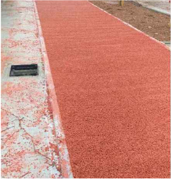
Esempio marciapiede in drainbeton (Typ.)
