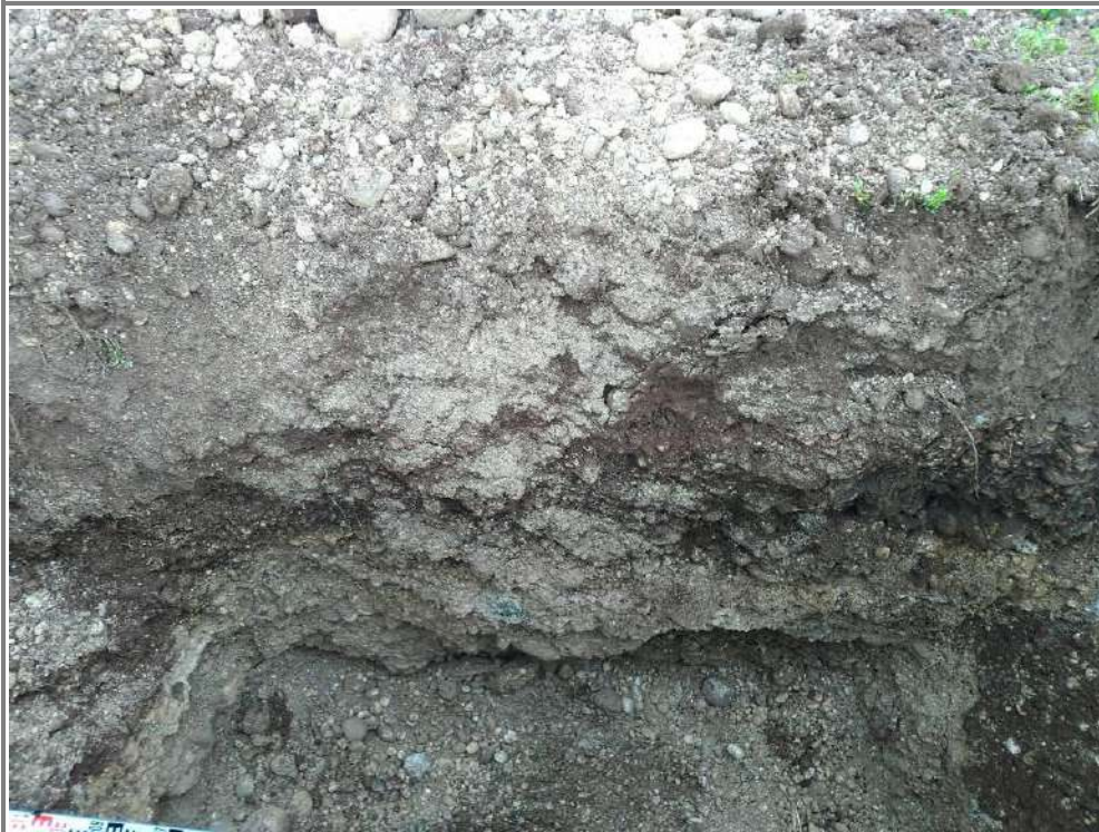
PARTICOLARE DI PARETE E DI FONDO SCAVO
