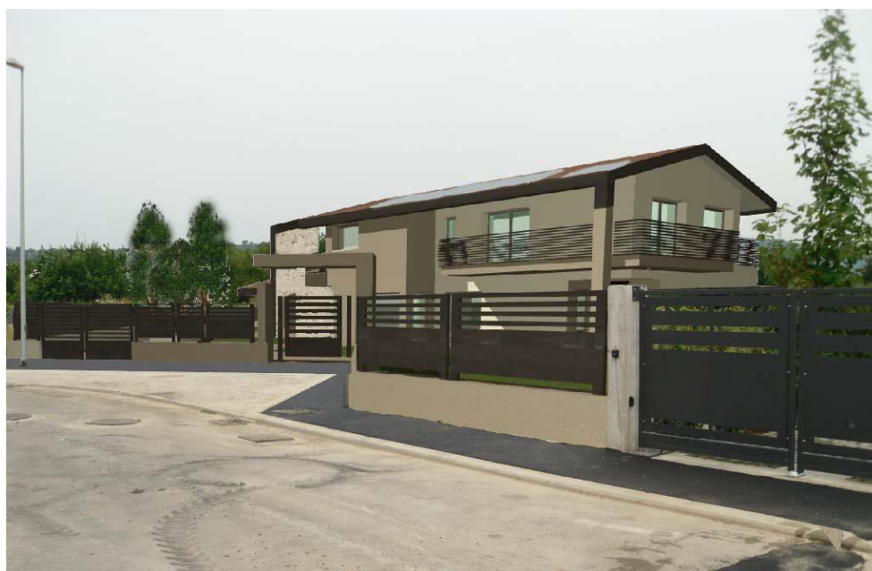
Vista dell'edificio bifamiliare percorrendo la strada di lottizzazione da est verso ovest.
