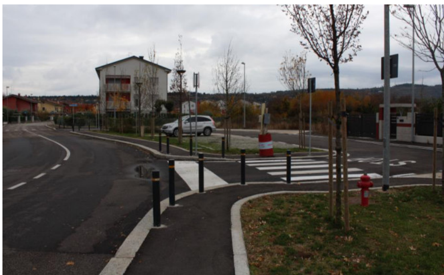
Area di PUA su via Pontedera – immagine successiva alla realizzazione delle opere di piano
