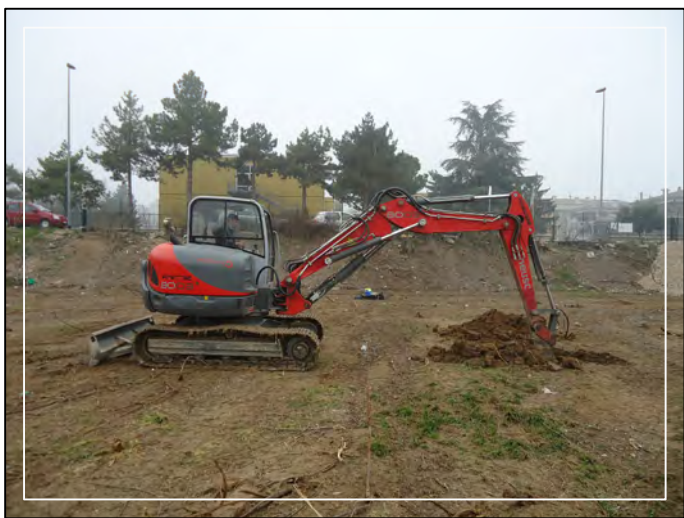
Postazione trincea "T3"
