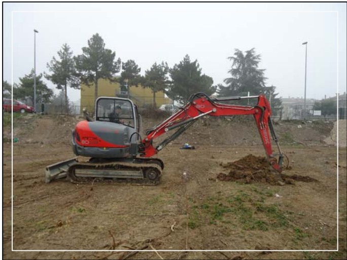
Postazione trincea "T3"
