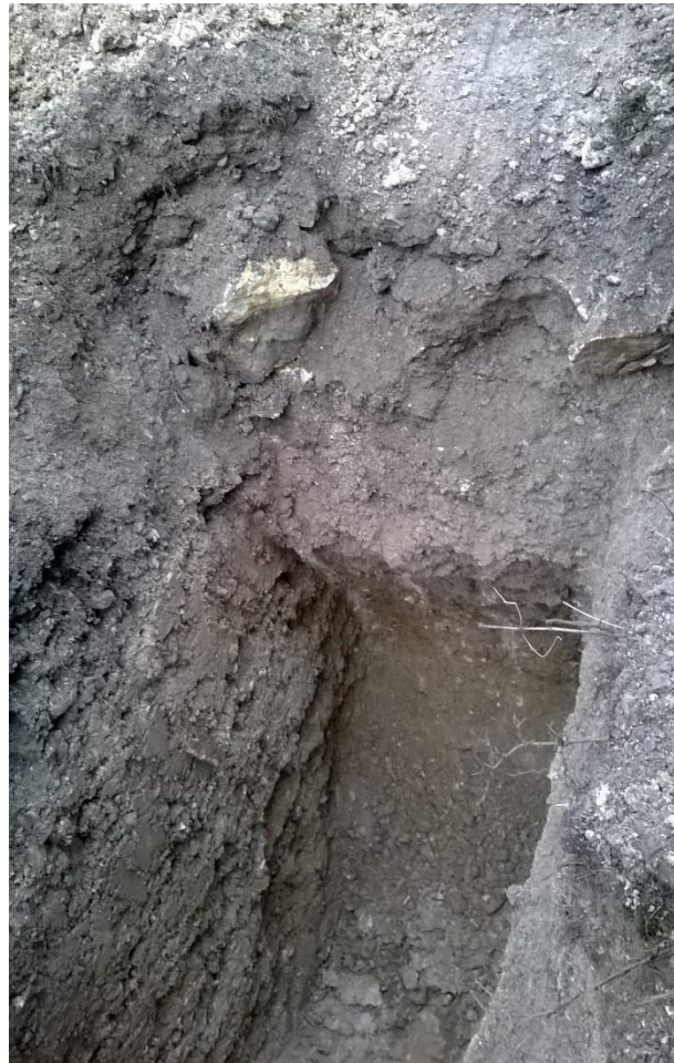
Fig. 4: fotografia della Trincea eseguita in sito.
