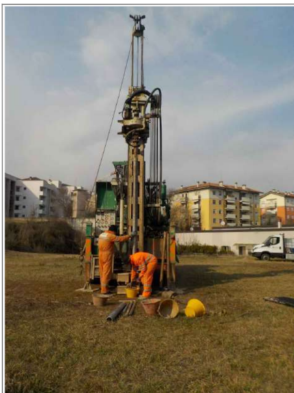
POSTAZIONE VISTA DA SUD SUD-EST
