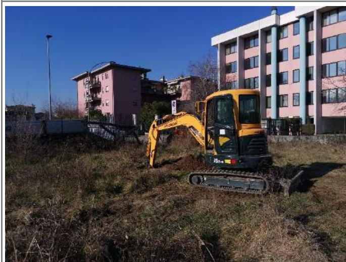
Fig. 25. Postazione di realizzazione del pozzetto per l'esecuzione della prova di permeabilità.
