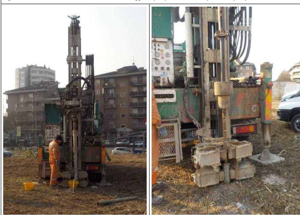
Fig. 23. Particolari delle fasi di esecuzione del sondaggio S1 (a sx) e delle relative prove SPT (a dx).
