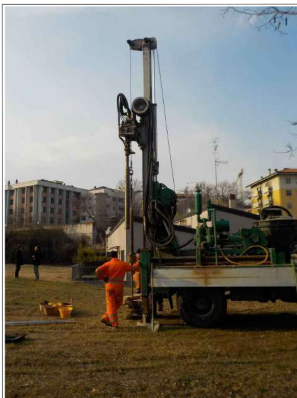
POSTAZIONE VISTA DA SUD EST
