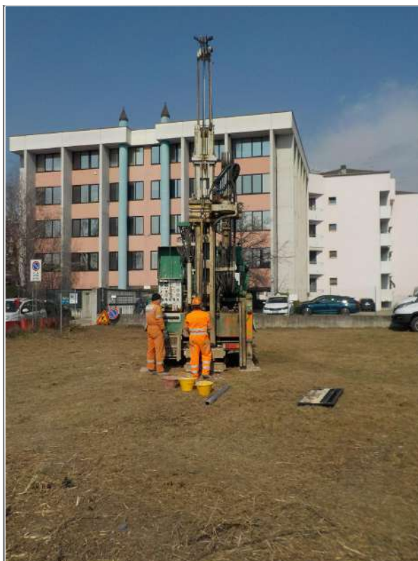
POSTAZIONE VISTA DA SUD
