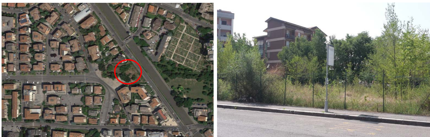
Figura 1 – A sx ortofoto estratta da www.googlemaps.it in cui si evidenzia l'area di intervento; a dx panoramica dei luoghi.
