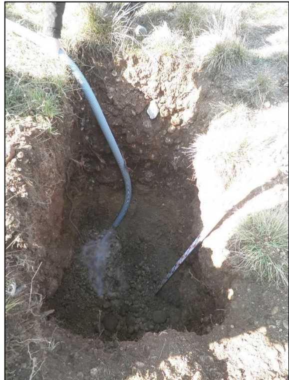
Fasi esecutive della prova di permeabilità P1: i livelli idrici all'interno del pozzetto di prova, delle dimensioni di 2,2 x 1,6 x 1,0 m, hanno raggiunto un'altezza massima di 5 cm.
