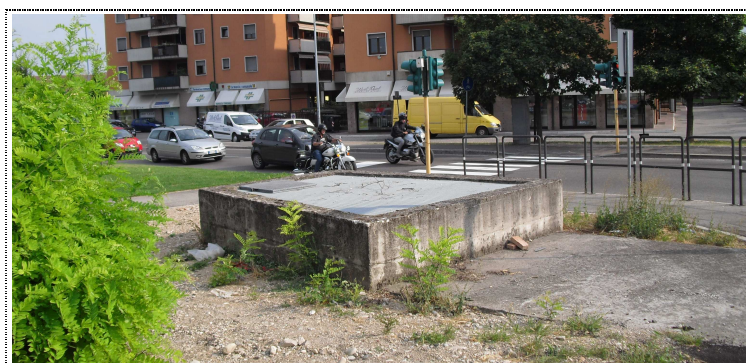
Fig. 4_ Manufatto di ispezione delle acque provenienti dal canale ramo di sinistra.
