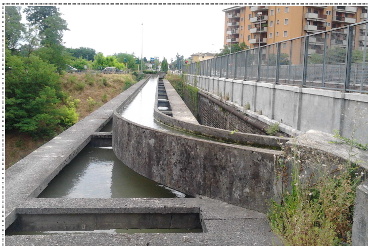
Fig. 1_ Canali in calcestruzzo di attraversamento del Canale Milani.
