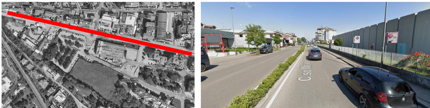
Figura 7 - localizzazione e foto SR11 "Padana Superiore" in corrispondenza ipermercato Rossetto
