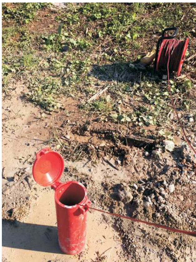
Rilievo della quota freatica all'interno del piezometro installato nel foro di sondaggio
