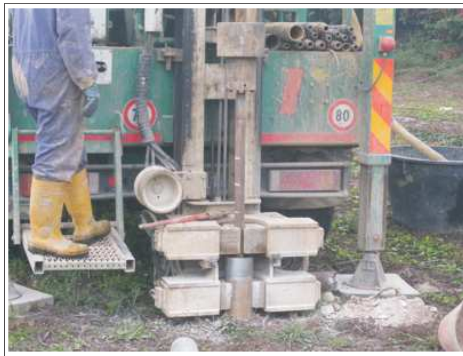
Esecuzione della prova SPT in foro
