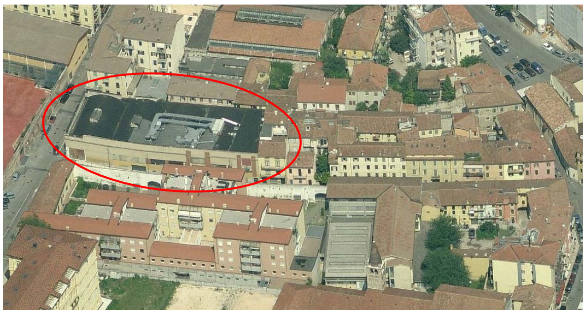
Area di intervento
