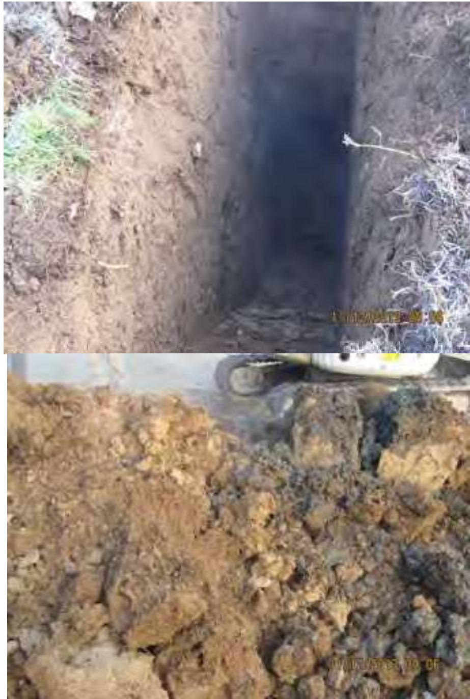
Fig. 6: lo scavo n. 2 e il terreno di risulta
