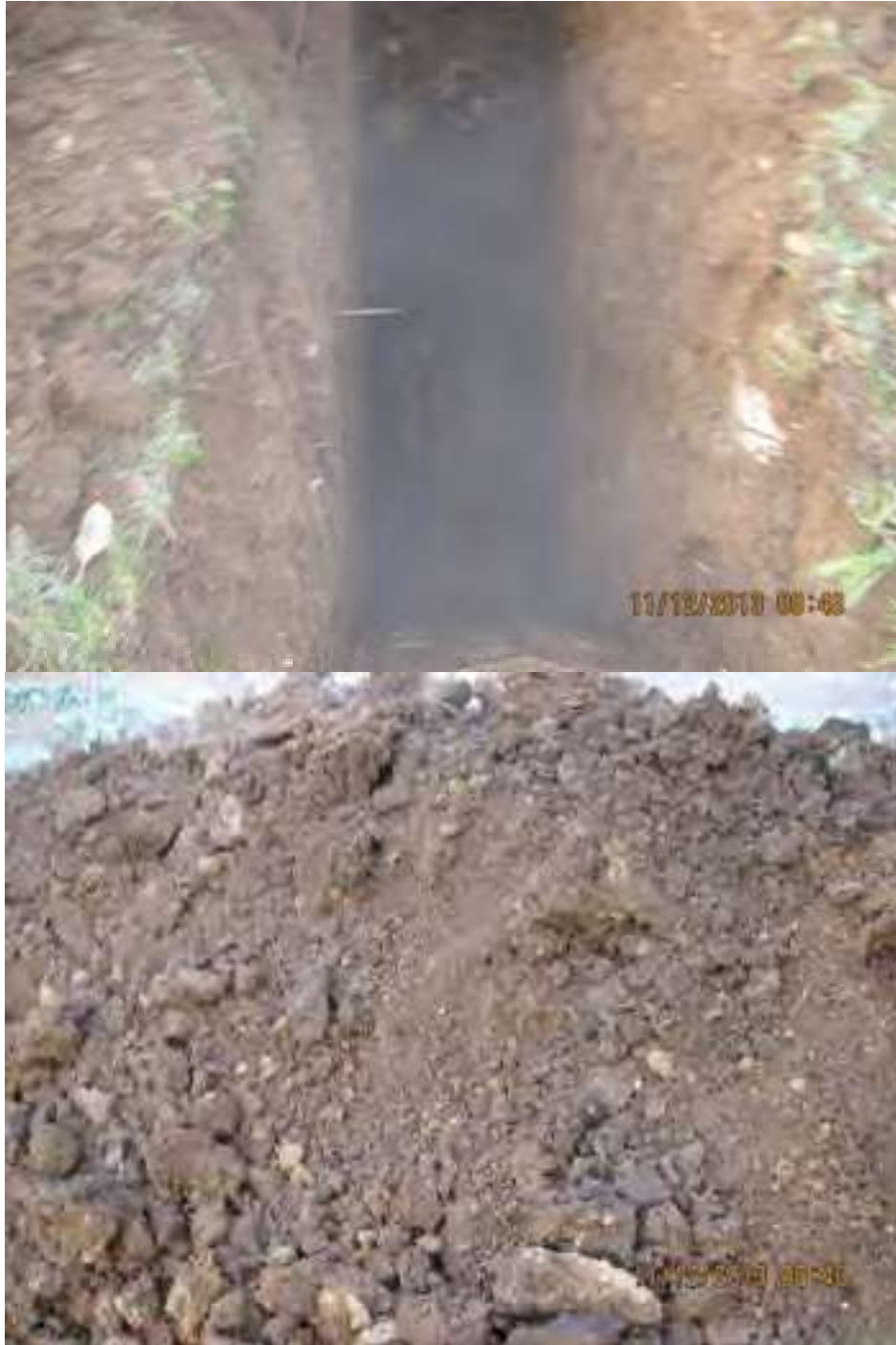
Fig. 5: lo scavo n. 1 e il terreno di risulta
