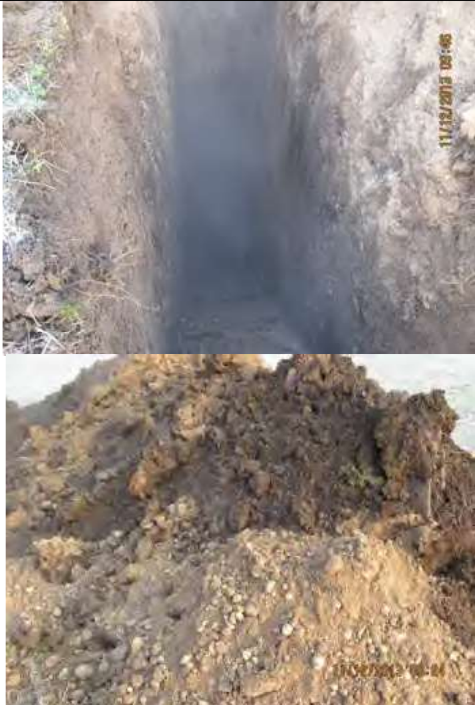
Fig. 7: lo scavo n. 3
