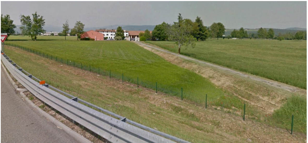
Vista dal raccordo tangenziale verso palazzina uffici
