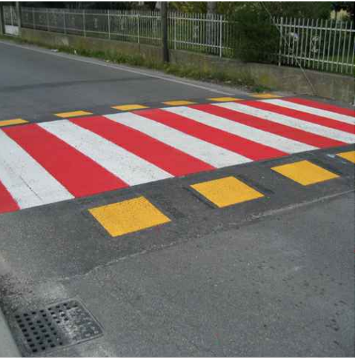
Immagine 2: Dispositivi di traffic calming per gli attraversamenti
