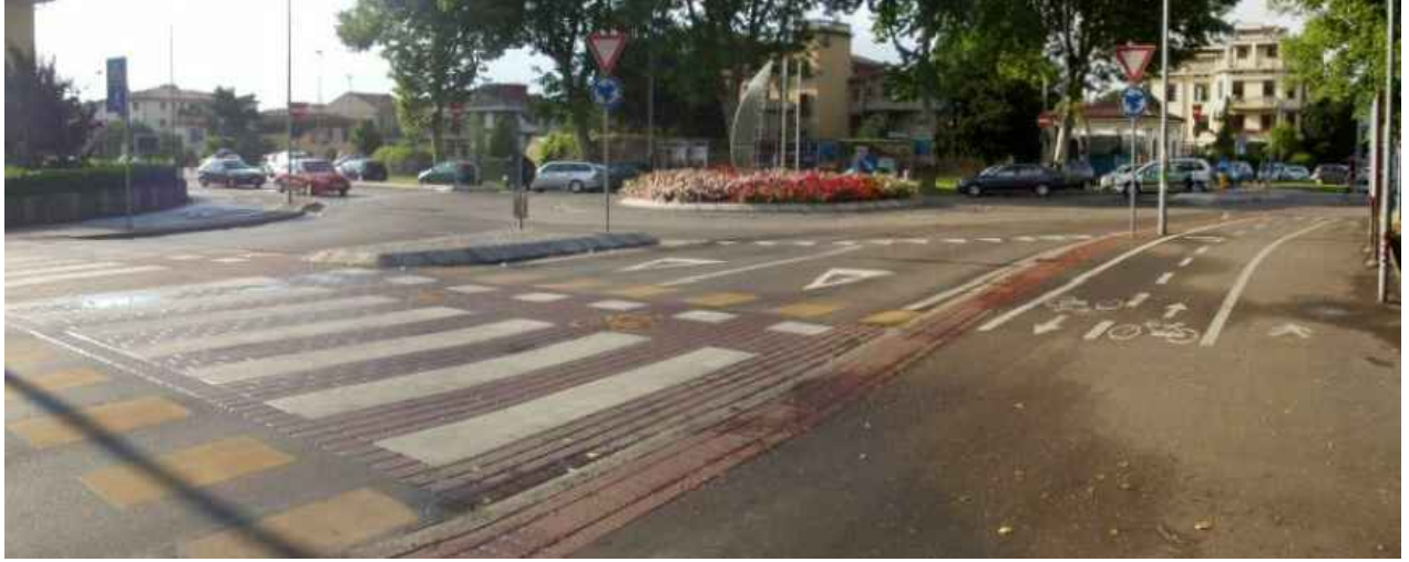
Immagine 3: Particolare dell'attraversamento a raso della pista ciclopedonale su rotatoria
