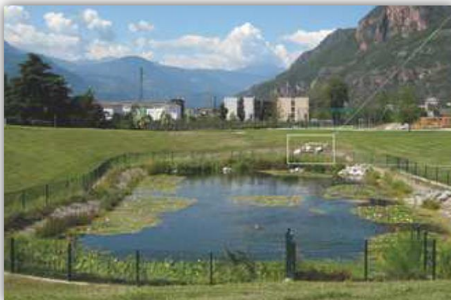
Figura 5-1: Esempio di bacino d'infiltrazione
