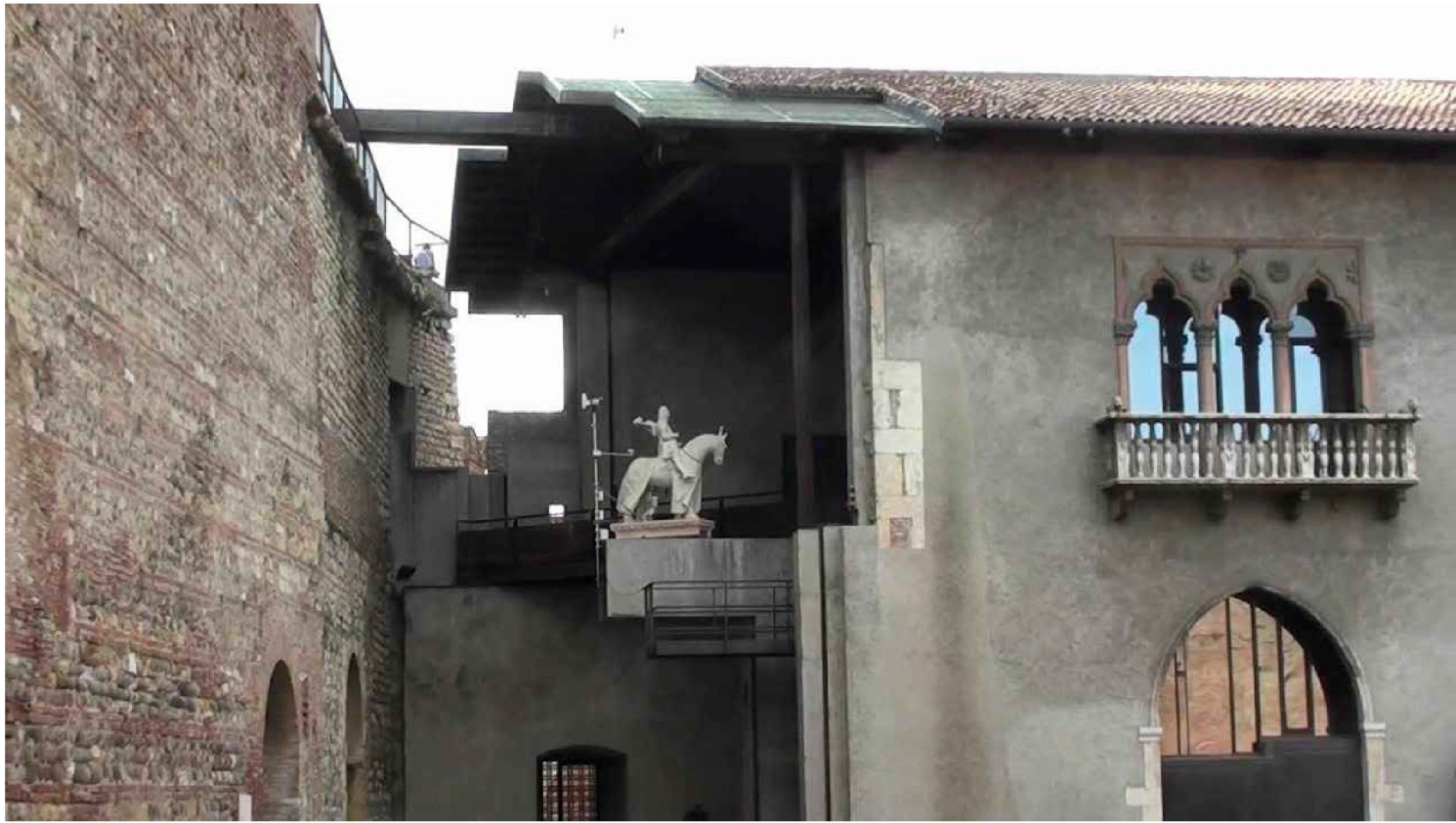
RIFERIMENTO COPERTURA IN RAME Castelvecchio_Verona
