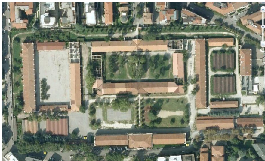
Ortofoto dello stato attuale
