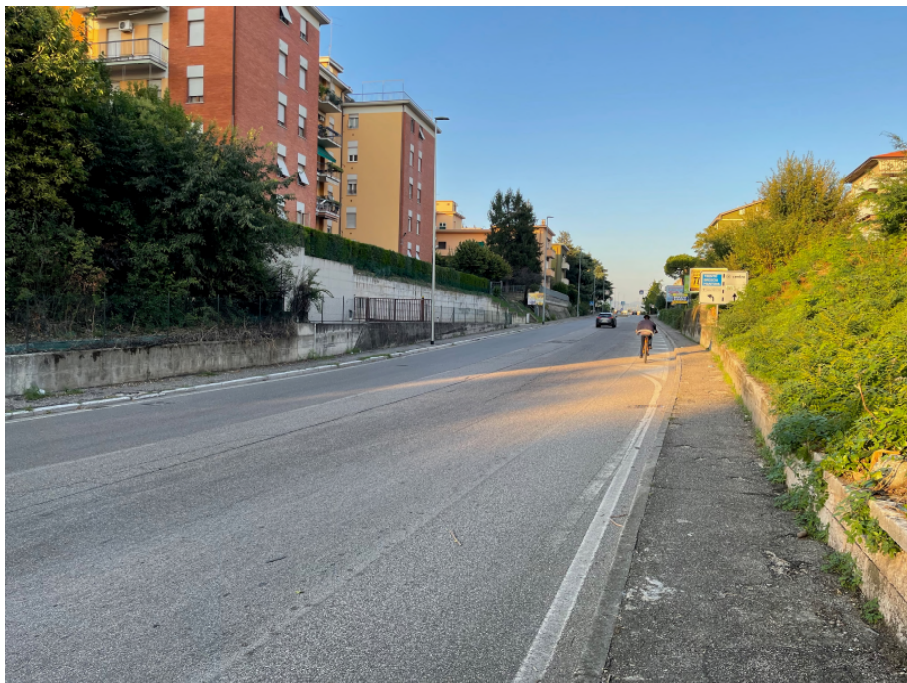
Figura 3 Stradone Santa Lucia, nel tratto interessato dall'intervento
