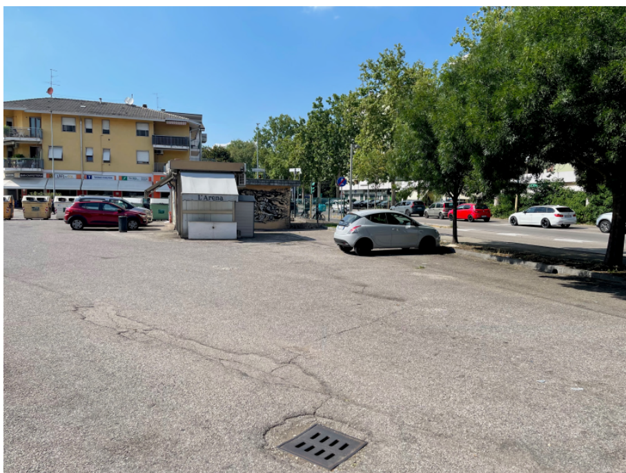
Figura 14 Parcheggio via dei Lamberti
