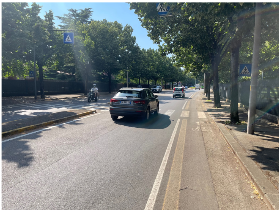
Figura 5 Via Po, tratto est
