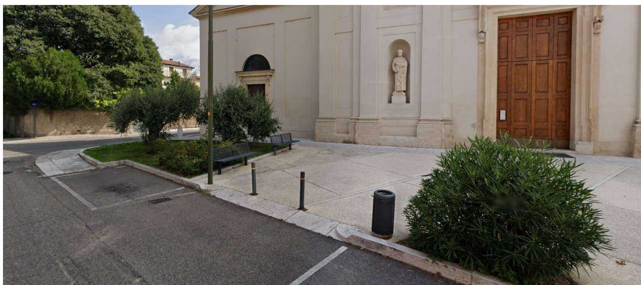
Piazza della Chiesa - dettaglio cordoli e scivoli di raccordo in pietra bianca della Lessinia
