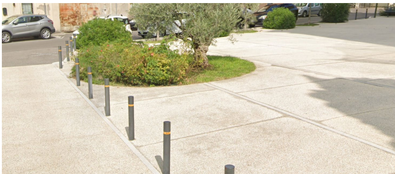
Piazza della Chiesa - dettaglio pavimentazione in graniglia lavata colorazione beige
