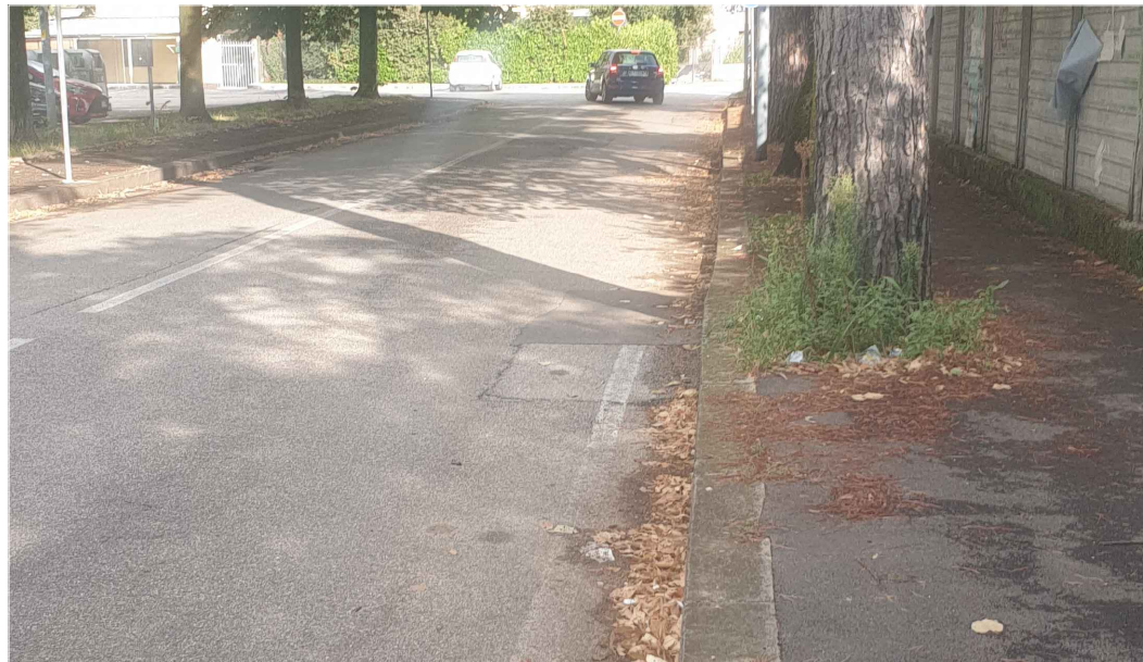
f10 - cordoli in pietra e marciapiede con fondo in asfalto
