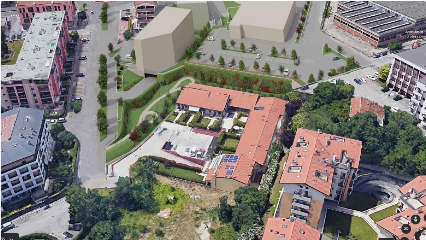
VISTA DA NORD
