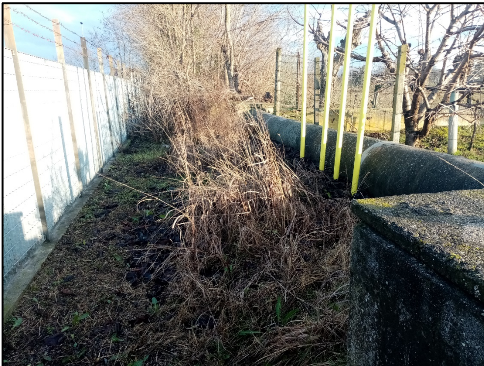
Figura 1: Vista canale consortile 86/141 che sarà oggetto di attraversamento da parte del metanodotto in progetto
