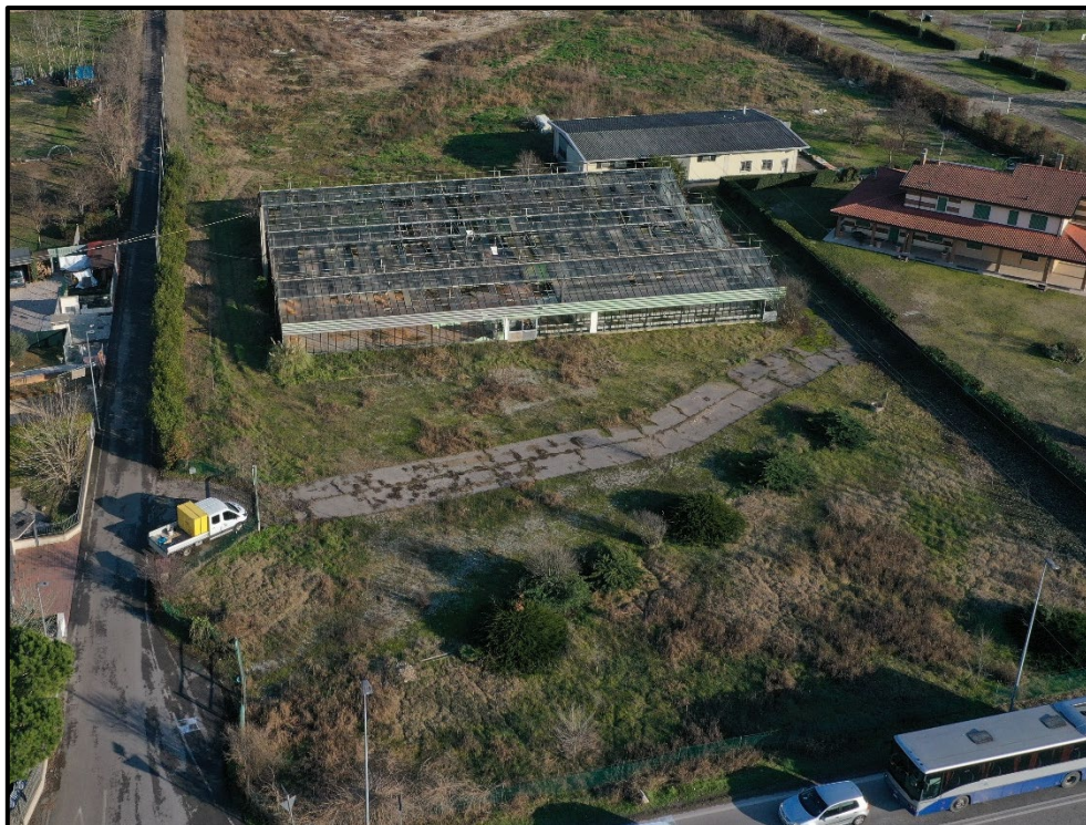
Figura 4: Vista del secondo attraversamento del canale 130/155 in corrispondenza della sezione attraversata dal metanodotto in progetto
