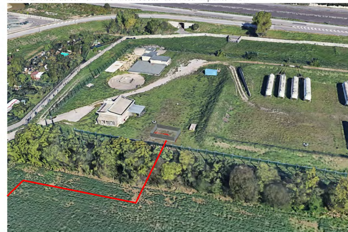
Foto 12: Vista aerea Terminale Metanodotto con Area Impianto PIDA
