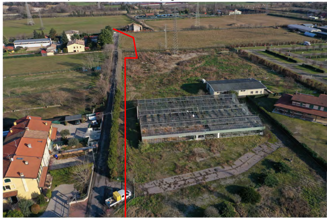
Foto 9: Vista aerea percorrenza metanodotto in progetto
