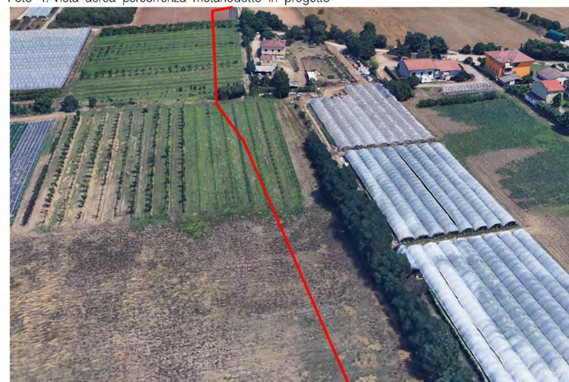
Foto 4: Vista aerea percorrenza metanodotto in progetto
