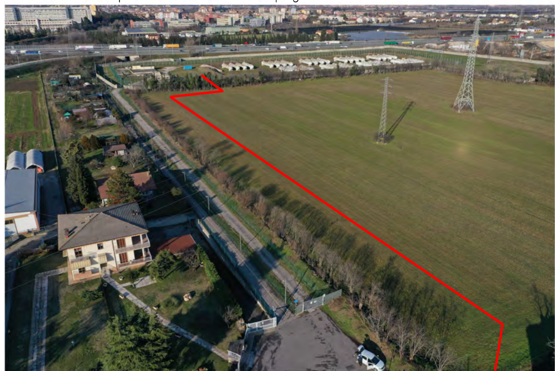
Foto 11: Vista aerea percorrenza metanodotto in progetto
