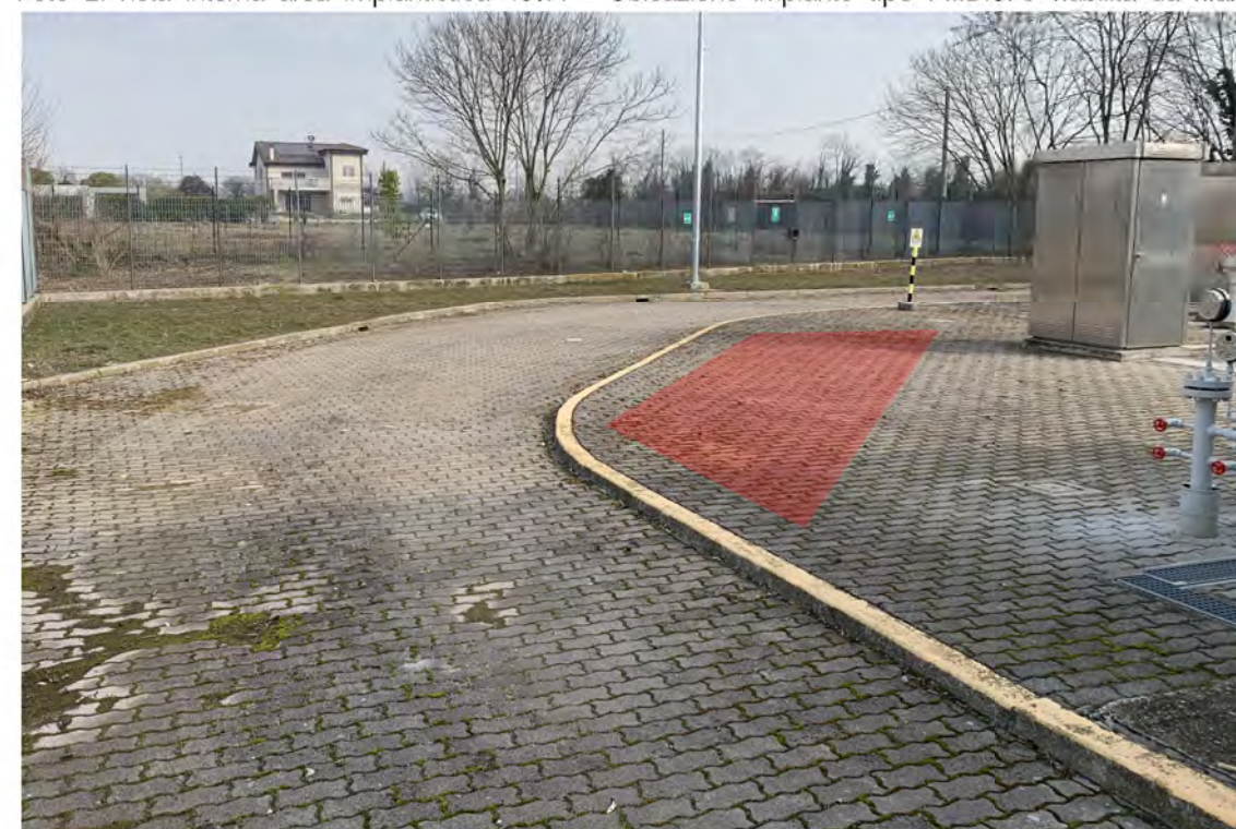
Foto 2: Vista interna area impiantistica 461/A – Ubicazione impianto tipo P.I.D.S. e viabilita' da rifare
