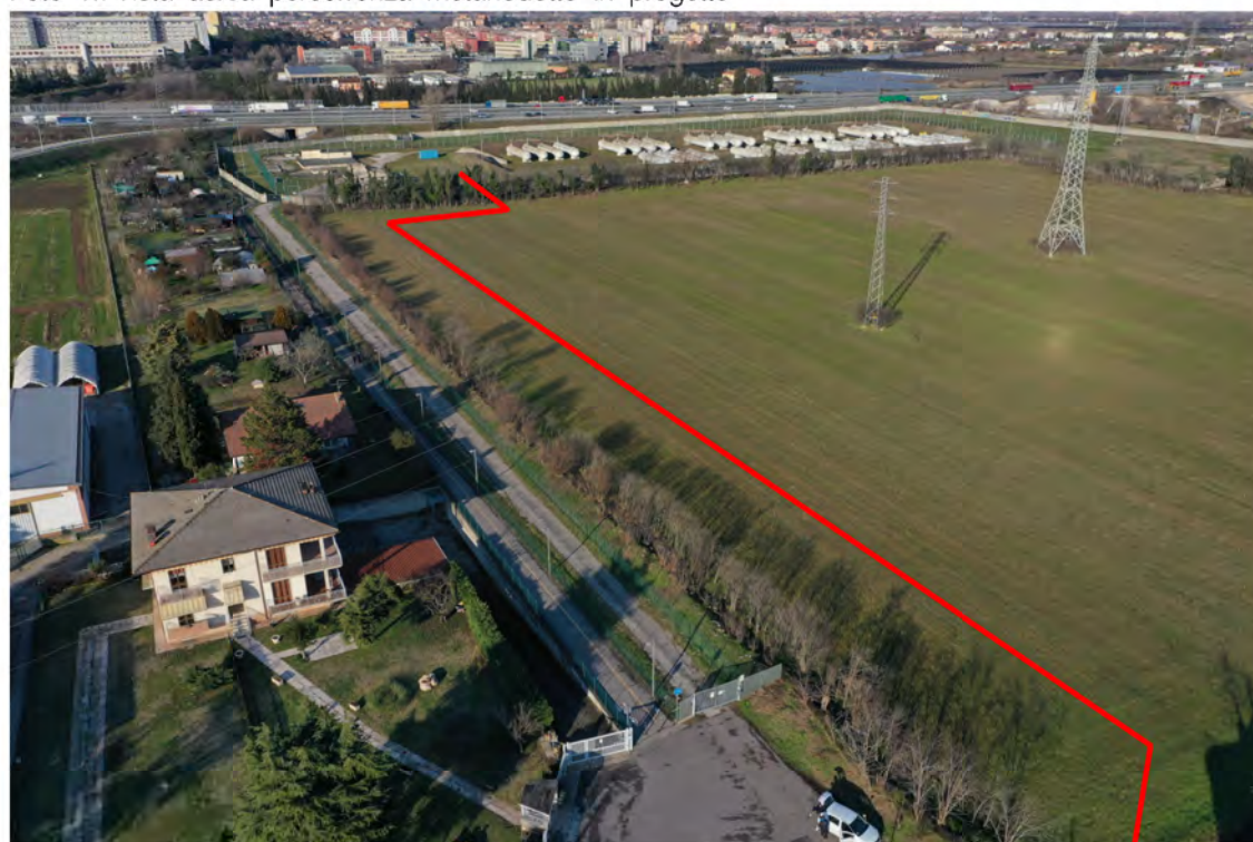
Foto 11: Vista aerea percorrenza metanodotto in progetto
