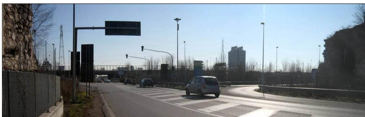
Intersezione 3 – SS12 e lo svincolo di ingresso-uscita Tangenziale Sud direzione VR Nord
