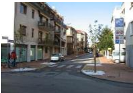
Porta di accesso al quartiere; una pedana rialzata con alberi ai lati dà continuità al marciapiede e fa rallentare i veicoli che entrano
