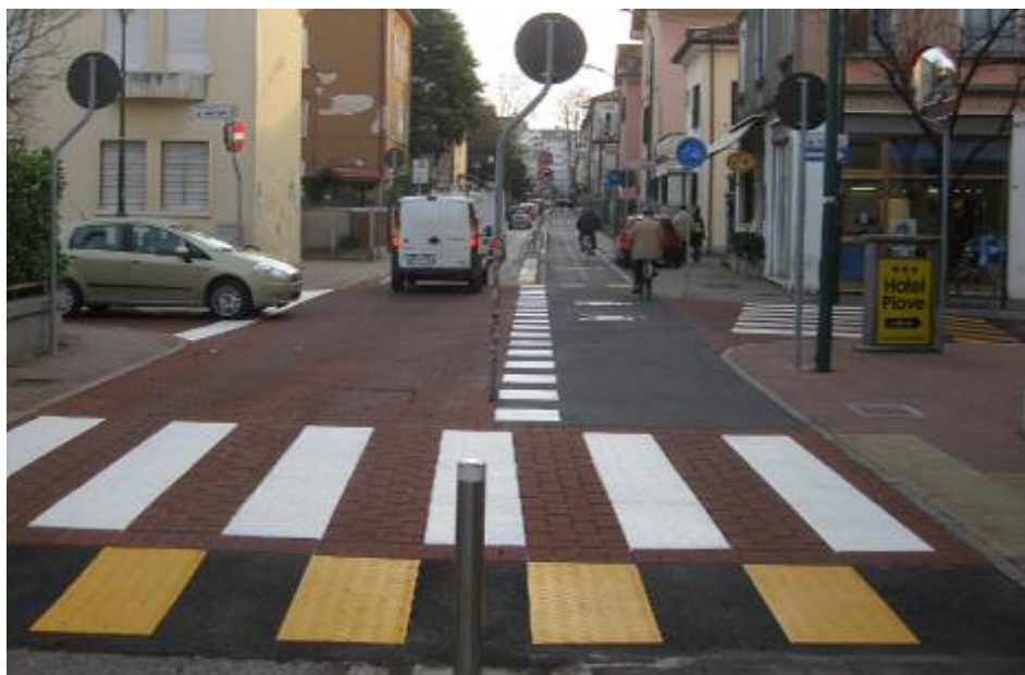
Intersezione tra pista ciclabile bidirezionale e viabilità ordinaria su incrocio rialzato, la chiarezza e completezza della segnaletica orizzontale assieme con le pavimentazioni perfettamente lisce conferiscono sicurezza e comfort
