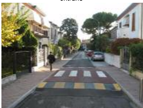
In ogni strada è stato realizzato un marciapiede largo 150 cm almeno da un lato per garantire una buona mobilità pedonale, sull'altro lato c'è spesso il parcheggio
