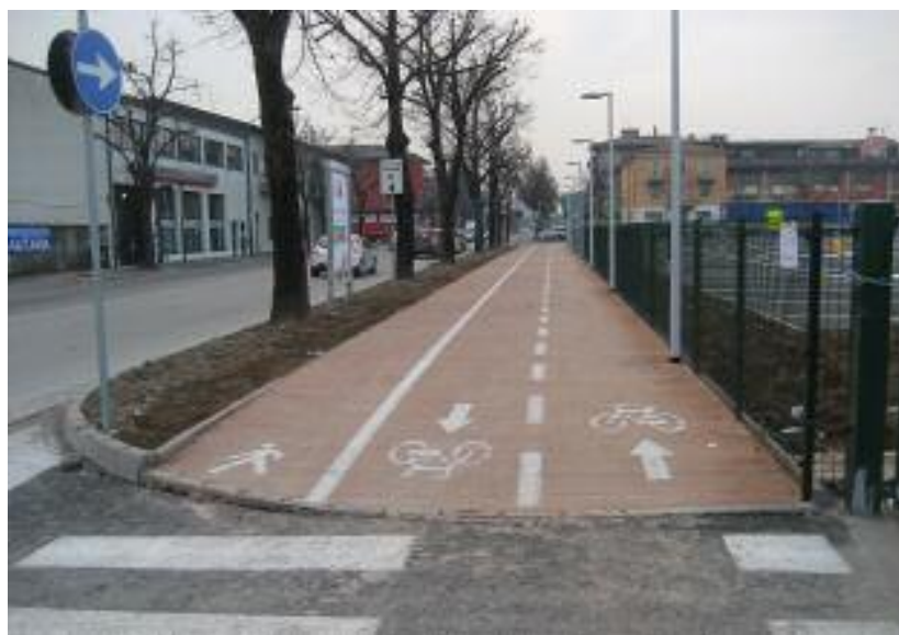
Esempio di nuova pista ciclabile con pavimentazione colorata, unica in città di Verona, con percorso ciclabile in posizione errata (la norma prescrive che sia a lato strada); colorazione e posizionamento del flusso ciclabile sono due elementi di disomogeneità con le altre piste ciclabili di Verona
