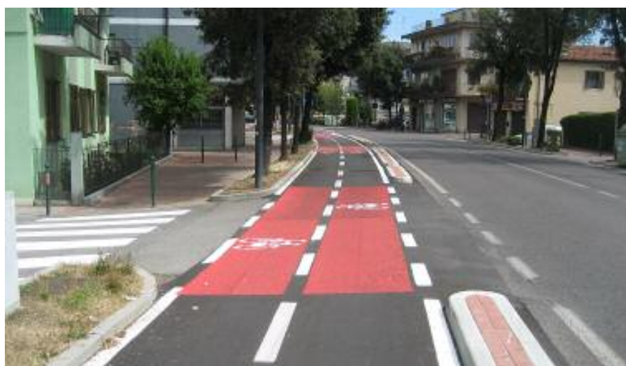
Pista ciclabile bidirezionale separata dalla carreggiata stradale dal prescritto cordolo separatore invalicabile largo cm 50. La perfetta visuale reciproca tra autoveicoli e biciclette, assieme alla pavimentazione rossa nelle zone di intersezione, conferiscono riconoscibilità e sicurezza
