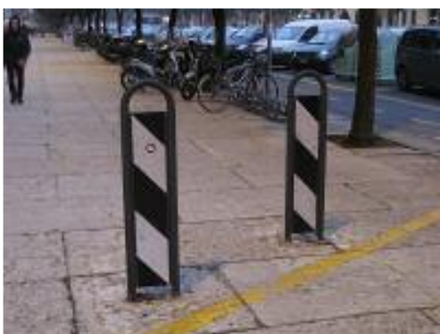
Esempio di dissuasore su pista ciclabile
