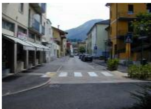
Porta di accesso con attraversamento pedonale su pedana in porfido
