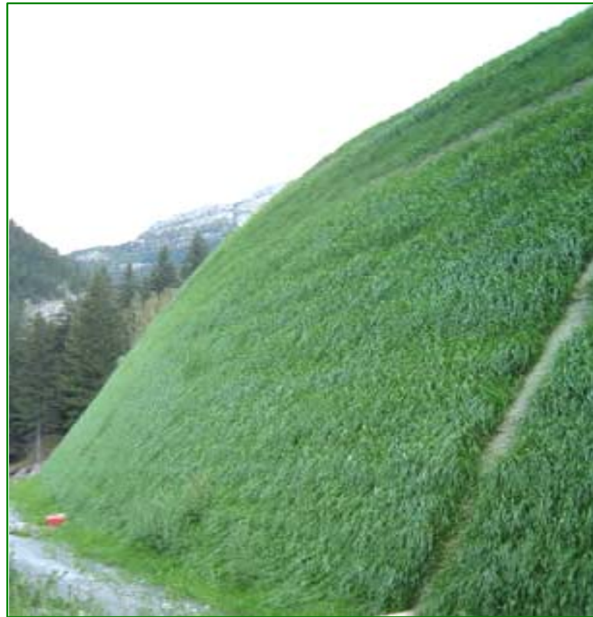
barriera antirumore in terra armata (la pendenza è di circa 70°)
