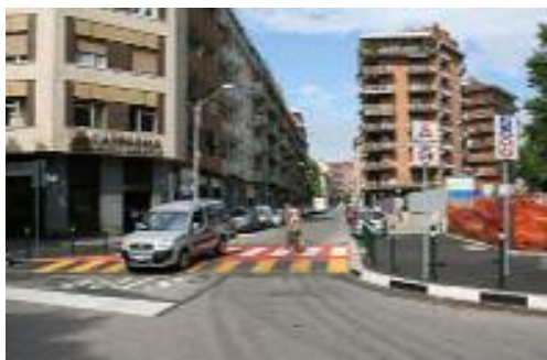
Porta di accesso con attraversamento pedonale su pedana
