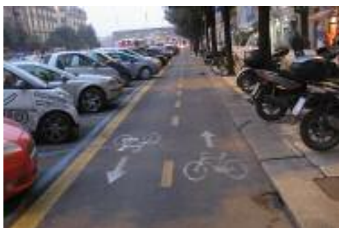
Uso di linee di margine gialle (non conformi) e margini disordinati
