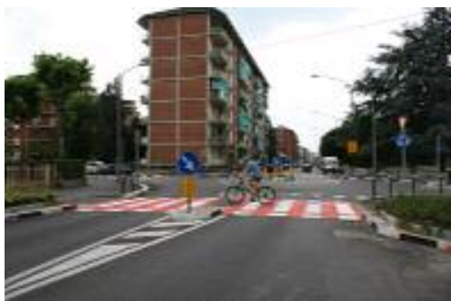
Rotatoria con attraversamenti ciclopeditoni a raso al contorno ma protetti da isoletta salvagente
