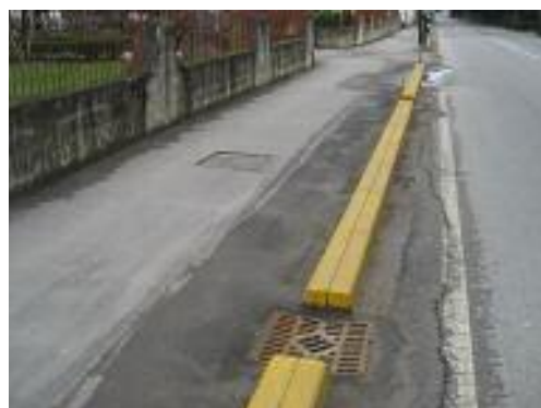
Doppio cordolo da cm 30, non a norma ma utilizzato talvolta in sezione ristretta
