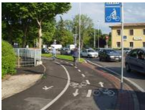
Rotatoria completamente circondata da percorso bidirezionale - Padova
