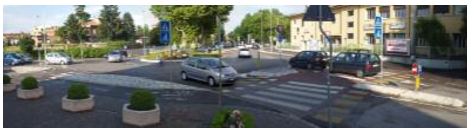
Esempio di rotatorie doppie completamente circondate da percorso bidirezionale - Padova
