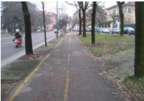
*Uso di linee di margine gialle (non conformi) e degradate*
