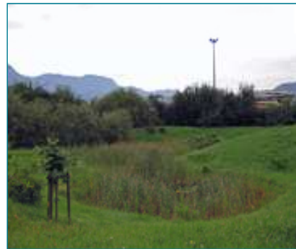
Vasche verdi con funzione di bacini di laminazione
